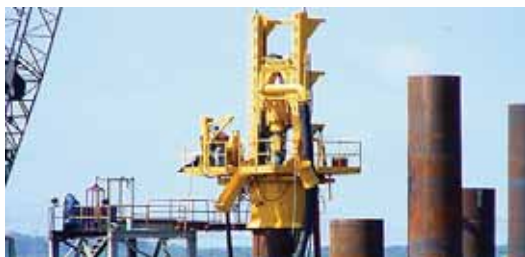
打桩机 Pile-top rig
